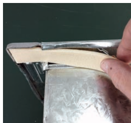
ダクトフランジに インナーテープを貼付け
