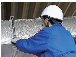
断熱ダクトピース同士を接続
